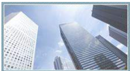
BM事業（ビルメンテナンス）
