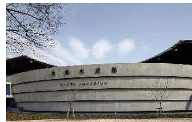
娯楽施設：京都水族館
